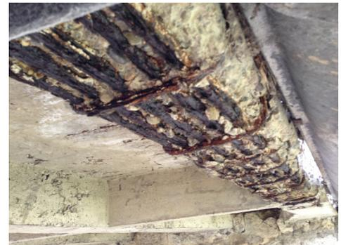
Als erste Massnahme wurde damals eine Lastbeschränkung auf 28 Tonnen ausgeschildert. Aus beiden Berichten geht hervor, dass sich der Zustand der Brücke von Jahr zu Jahr mehr verschlechterte. Der Schadenverlauf beschleunigte sich zunehmend. Dadurch wurden die Tragreserven bereits stark reduziert.
