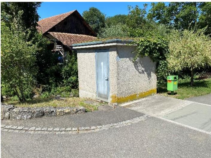
Das Abwasserpumpwerk «Unterdorf» Baujahr 1973 entspricht nicht mehr den heutigen technischen Anforderungen. Die elektrische Einrichtung führt vermehrt zu Störungen. Die Sicherheitsvorschriften für den Unterhalt der Anlage sind nicht mehr gegeben.
