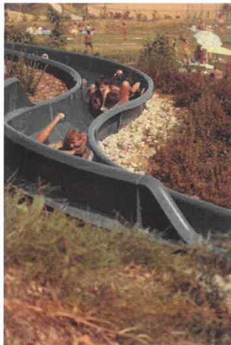
**Bild 19:** *Muldenrutsche aus GFK-Material.*
