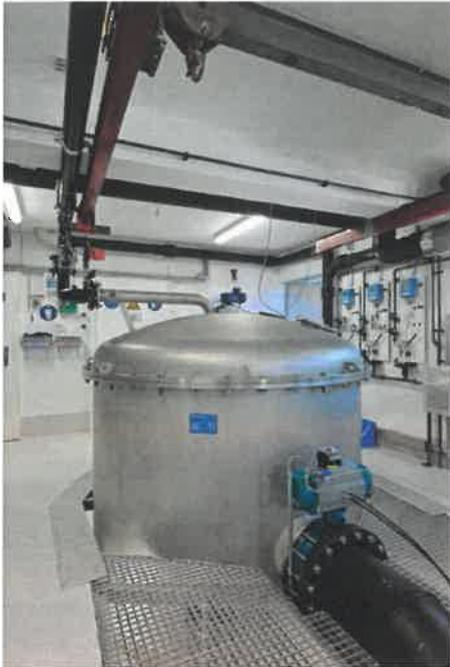
*Bild 33: Anschwemmfilter Terrassenbad Baden. Baujahr 2017, Umwälzleistung 350 m<sup>3</sup>/h.*
