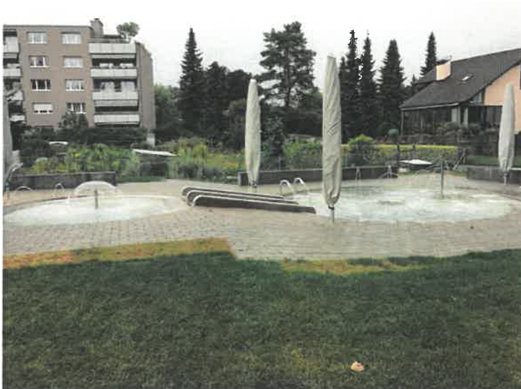
Bild 22: Schwimmbad Weiden, Dornach. Sanierung 2017. Das bestehende Betonbecken wurde zurückgebaut und durch ein neues aus «Edelstahl Rostfrei» ersetzt.
