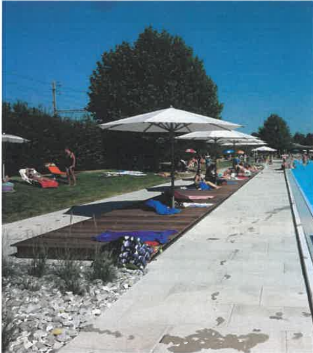
Bild 24: Schwimmbad Gossau/SG. Umgangsbereich mit Zementplatten und Holzliegerosten.
