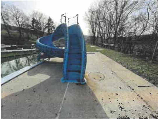
Bild 15: Beliebte Kinderrutsche aus GFK-Material. Am Ende der Nutzungsdauer.
