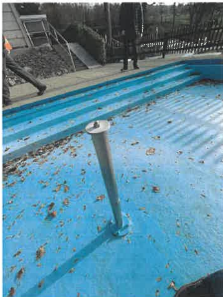
Bild 20: Planschbecken mit rauer Belagsfläche, jährlich mit Anstrich geflickt.
