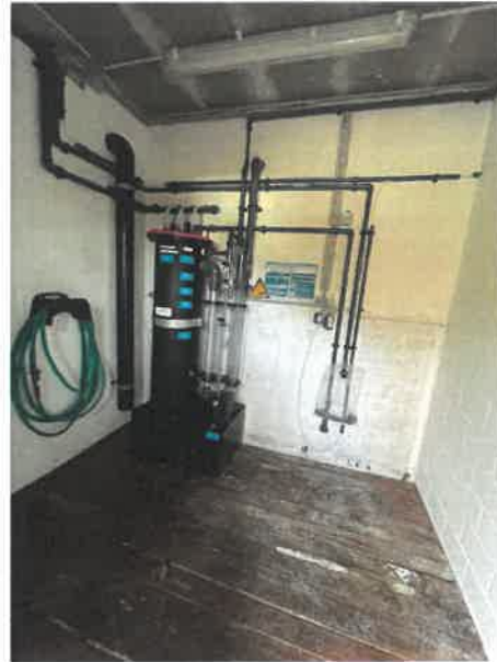
Bild 31+ 32: Desinfektions- und Neutralisationsanlagen mit Granudos-Calciumhypochlorit und Schwefelsäuredosierung. Diese Anlagen haben 2005 die Chlorgasdosieranlage ersetzt. Sie präsentieren sich in einem gut gewarteten Zustand.
