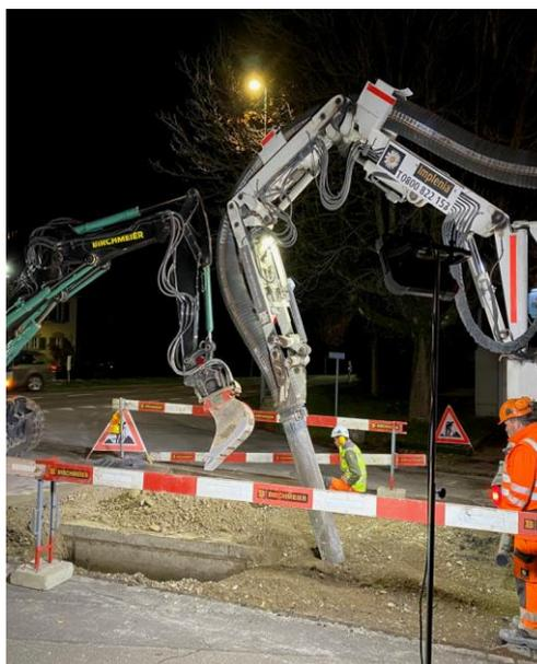
Fast die ganze Nacht musste am Graben bis auf rund 3.00 Meter Tiefe und an der Reparatur der Leitungen gearbeitet werden. Die Weidgasse war über Tage für den Verkehr gesperrt.
