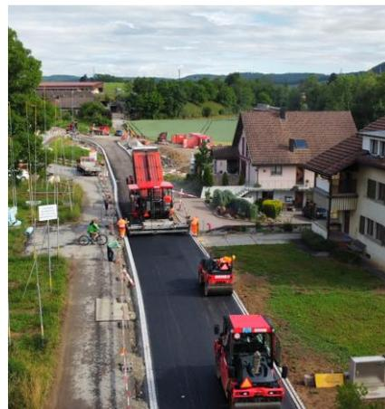
In der zweiten Berichtsjahrhälfte wurden die Arbeiten an den Werkleitungssanierungen im gleichen System bis zur Kreuzung Schlattstrasse fortgesetzt. Der bereits frühe Kälteeinbruch im November hat dazu geführt, dass nicht mehr alle Randabschlüsse eingebaut werden konnten. Mitte Dezember erfolgte dennoch termingerecht der Belagseinbau auf dem zweiten Teilabschnitt.
