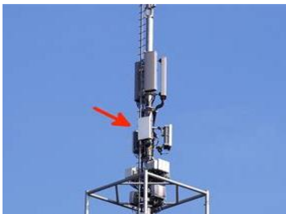
Optisch wahrnehmbare Mobilfunkantenne (adaptiv) Quelle: funkstrahlung.ch
